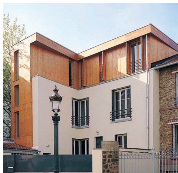
Une surélévation en bois a permis d'agrandir considérablement ce bâtiment (où aucune emprise supplémentaire au sol n'était possible), tout en résolvant un problème de déperditions thermiques par le toit grâce au pouvoir isolant du bois.
