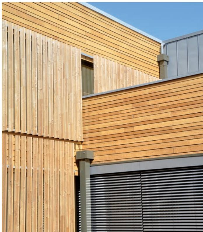
En bardage isolant et brise-soleil, le bois assure un confort d'été accru au sein de ce bâtiment.
